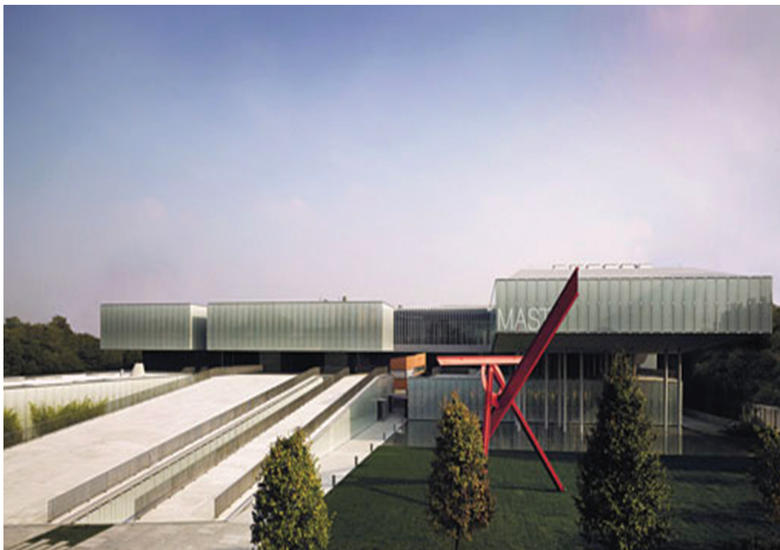
6 Facciata del MAST - Bologna
